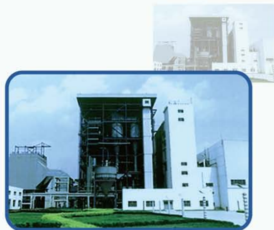
GP-CFB410/9.8-M 锅炉外景
